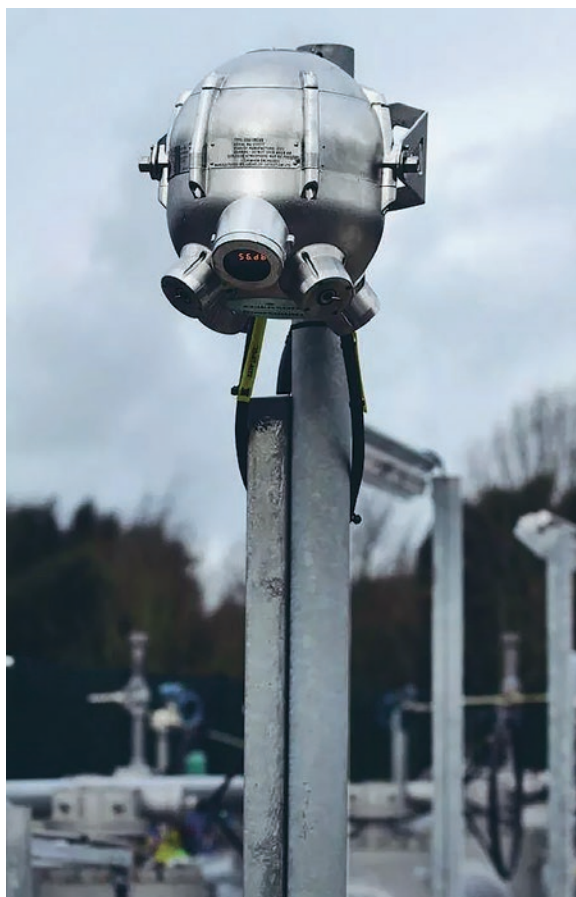
Fot. 1. Akustyczny czujnik wycieku gazu, taki jak Incus™ Ultrasonic Gas Leak Detector firmy Emerson, potrafi wykryć ultradźwięki powstające podczas wycieku i wskazać ogólny kierunek do miejsca awarii.
