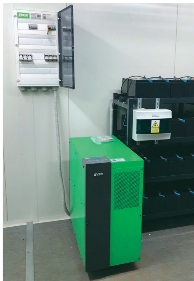
Fot. 1. UPS EVER POWERLINE GREEN 33 PRO dzięki możliwości podwójnego przetwarzania energii (separacji energetycznej) umożliwia generowanie na wyjściu jednostki napięcia o najwyższej jakości parametrach VFI-SS-111.
