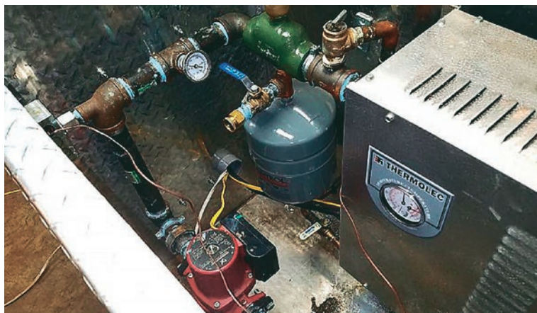
Fot. 2. Budowa układu testowego.
