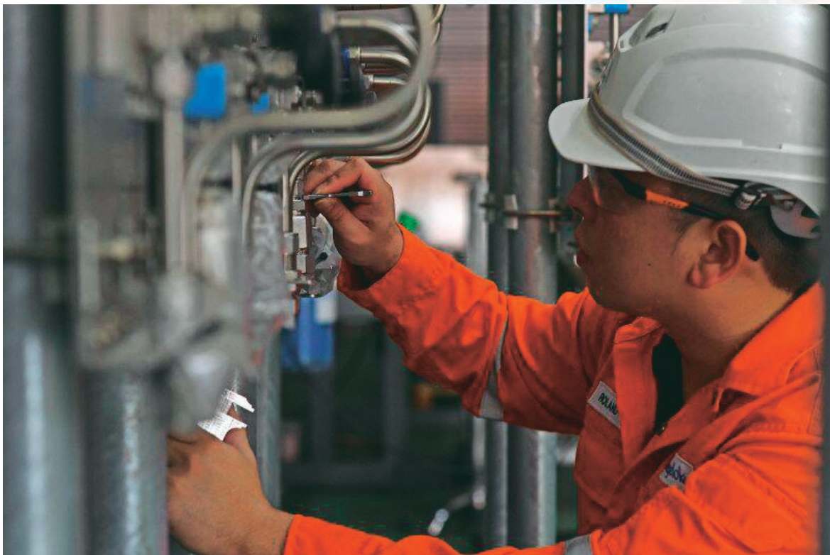
Ilustracja 4: Przeprowadzanie kontroli szczelności złączy w celu upewnienia się, że są one odpowiednio dokręcone, to jedna z regularnych czynności wykonywanych osobiście, którą można usprawnić za pomocą technologii wirtualnej. Dzięki uprzejmości: Swagelok Company
