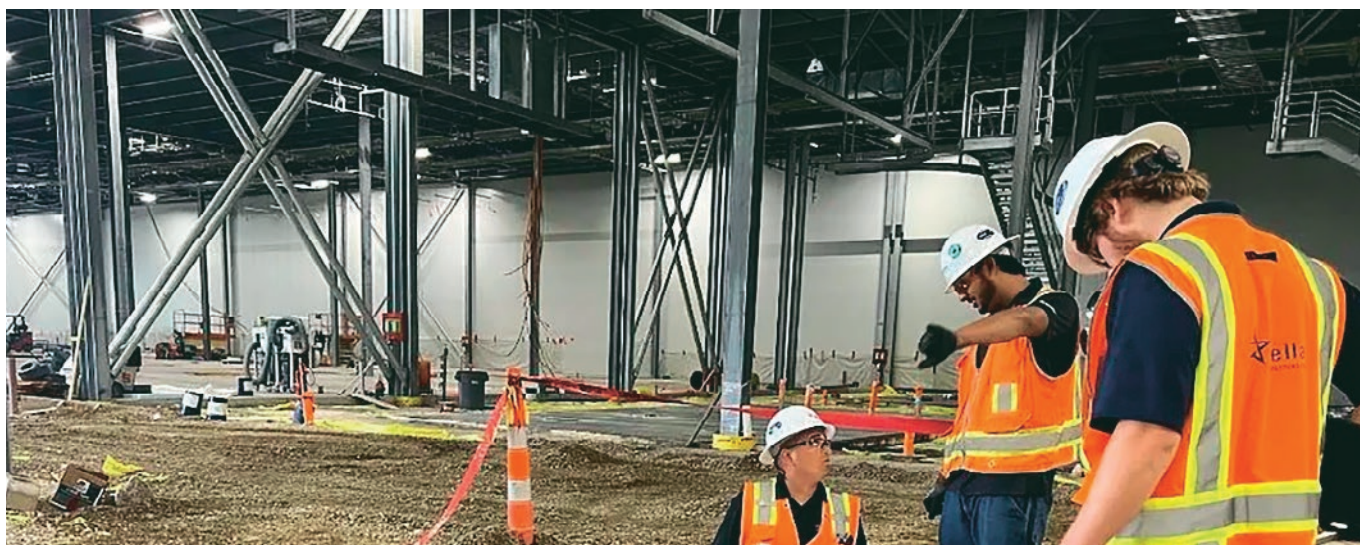
Każdy pracownik firmy Stellar jest zobowiązany do noszenia środków ochrony indywidualnej (ŚOI), w tym kasków ochronnych, okularów ochronnych itp. przez 100% czasu przebywania w aktywnym obszarze budowy. Dzięki uprzejmości: Stellar
