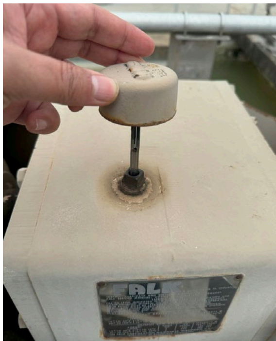
Ilustracja 3: Napęd zębaty progresywnej pompy wężkowej. Dzięki uprzejmości: Upper Occoquan Service Authority
