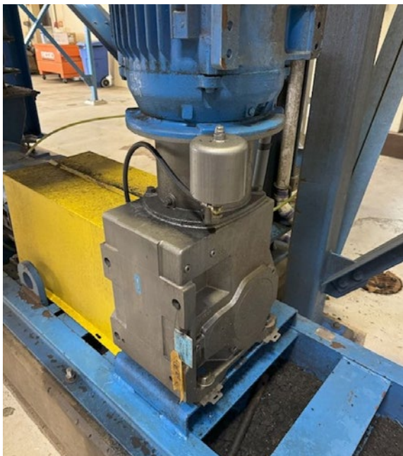
Ilustracja 5: Napęd zębata progresywnej pompy wnekowej. Dzięki uprzejmości: Upper Occoquan Service Authority
