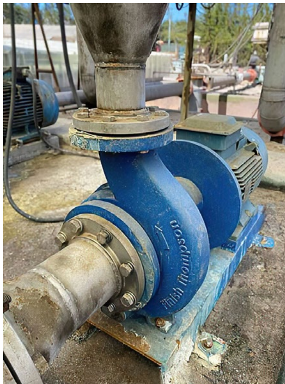
Rysunek 3: Pompy z napędem magnetycznym mogą obsługiwać najostrożniejsze chemikalia, w tym kwas siarkowy. Dzięki uprzejmości: Finish Thompson
