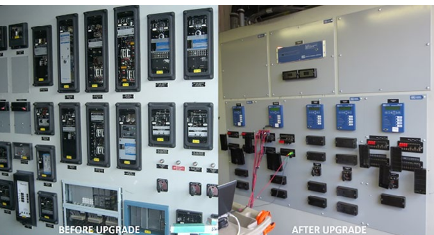
Foto 1: Przed i po modernizacji przełącznika zabezpieczającego.
