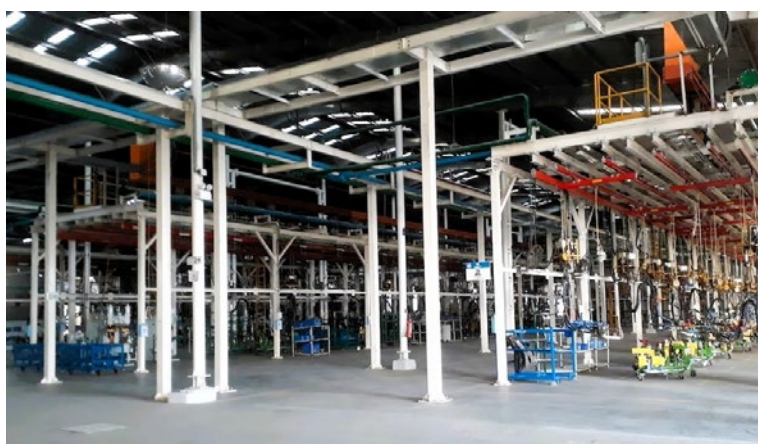
Foto 1: Wnętrze dużego obiektu przemysłowego z metalowymi belkami, rurami i maszynami, z przestronnym układem i betonową podłogą.
