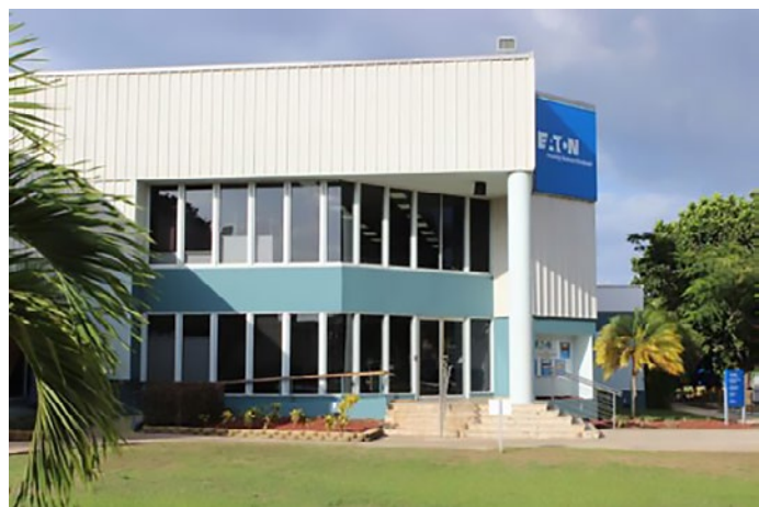
Foto 1: W swoim zakładzie w Arecibo firma Eaton produkuje wyłączniki automatyczne używane w domach, budynkach i zastosowaniach przemysłowych. Dzięki uprzejmości: Eaton.
